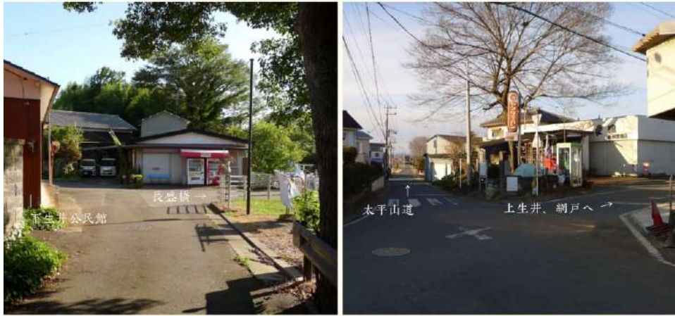
旧恩川の橋筋(長盛橋)の北。下生井、生井地区。2021/08/03
